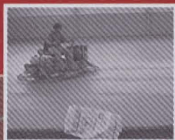
Talochagem mecânica
